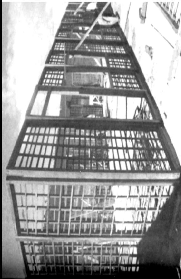
Painéis modulados e pré-fabricados em barro armado.
