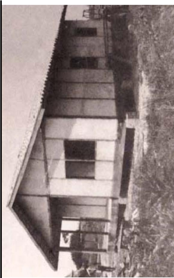
Habitação finalizada elaborada em painéis modulados e pré-fabricados em barro armado.
