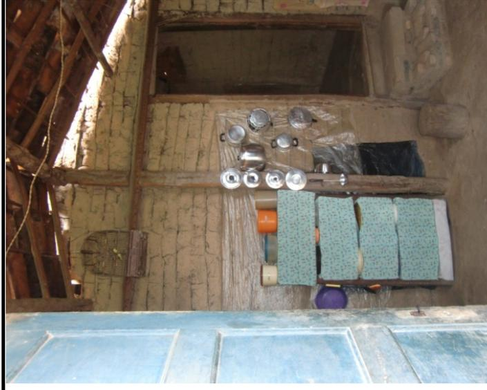
Exemplo de estrutura principal tipo “Armações” tipicamente utilizada para taipa de sebe ou taipa de sopapo com preenchimento em barro aplicado.
